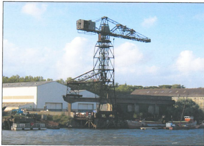
La grue marteau - appelée ainsi en raison de son profil asymétrique - dernière grue historique des chantiers navals de Nantes, a été rachetée par la Ville l'été dernier. Après la grue Titant jaune (1989) et la grise (2005) sur l'île de Nantes, la noire qui orne le bas Chantenay est à son tour sauvée.
